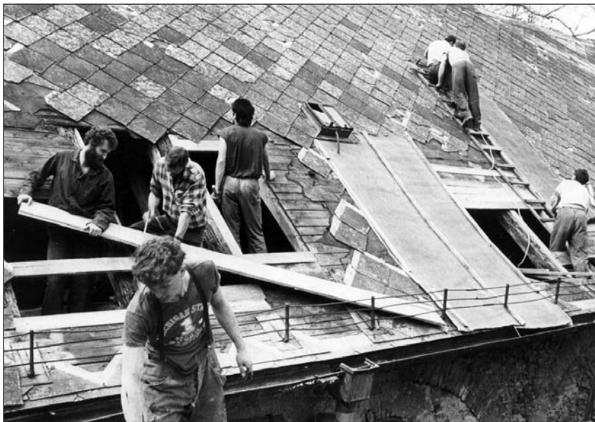
Oprava strechy kláštora v Marianke, 80. roky (Zdroj: Archív Mikuláša Hubu)
