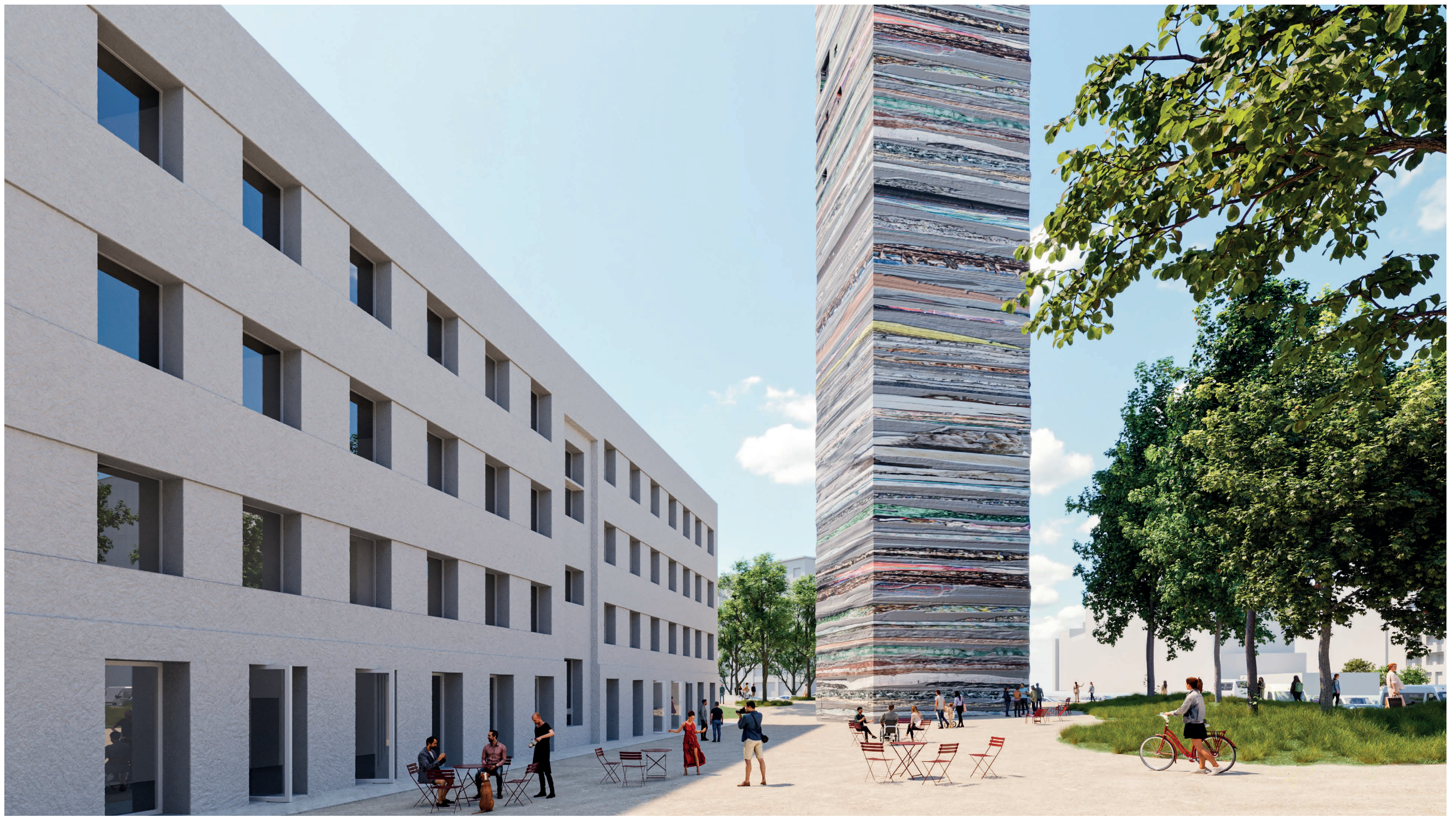
Veža pôsobí ako výsek geologických sedimentov, ako monumentálny pamätový vrt naprieč vrstvami zmaterializovaného času. Priemyselné materiály ako betón sú kombinované s prírodnými surovinami ako kameň, odpadovými materiálmi ako sklo, keramika, plast, textil a elektro, aj organickými prvkami ako kosti a drevíny. Otvorený parter hlavnej budovy vznikol znížením terénu. Okolo existujúcich stromov sú vytvorené terénne nerovnosti s ohľadom na rozpätie ich koreňového systému. Zelené ostrovy pod stromami sú vysadené trávno-bylinným spoločenstvom.
