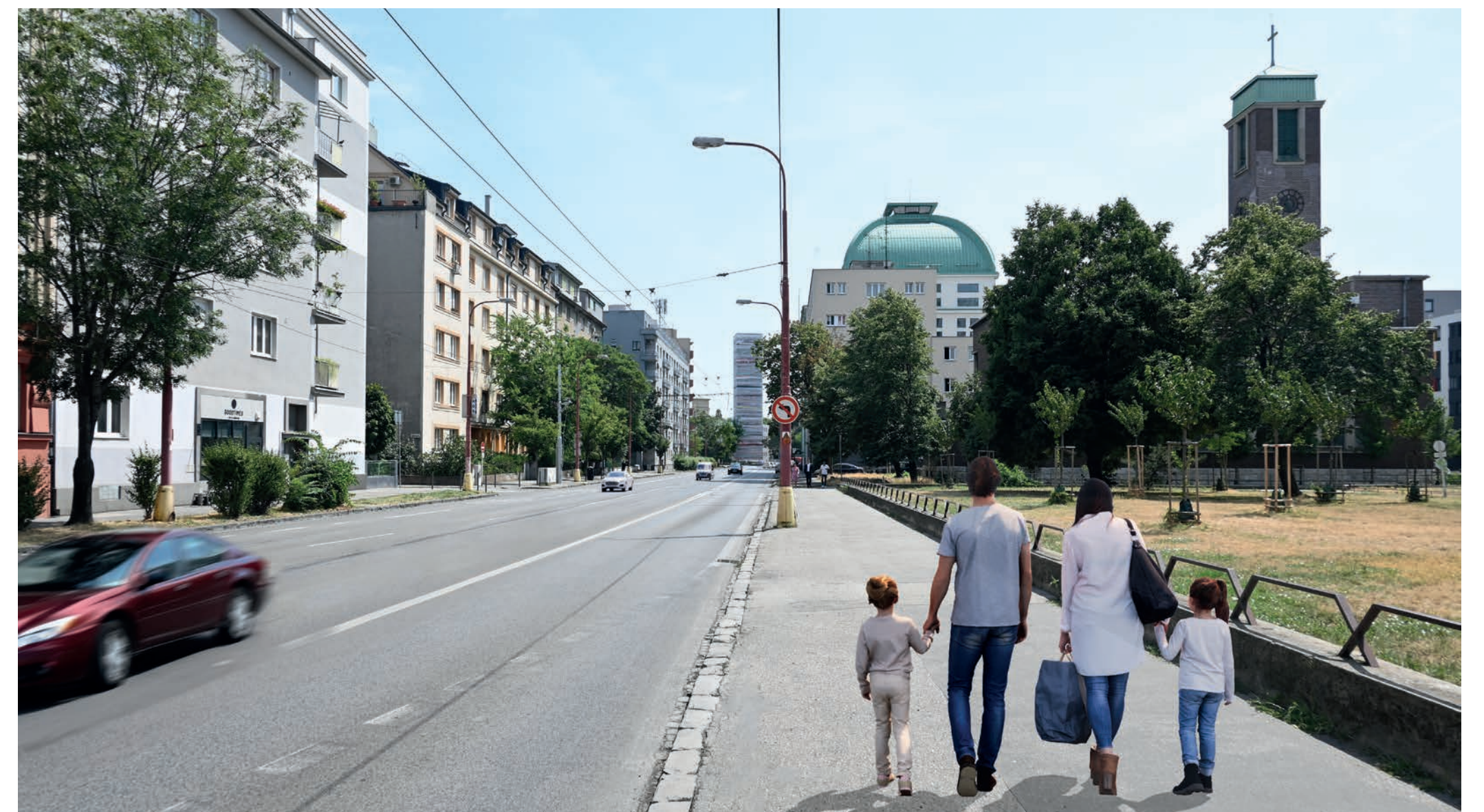
Veža vytvára pohľadovú dominantu časti vonkajšej mestskej okružnej triedy (Legionárska ulica) na jej krížení s významnou radiálou (Križna).
