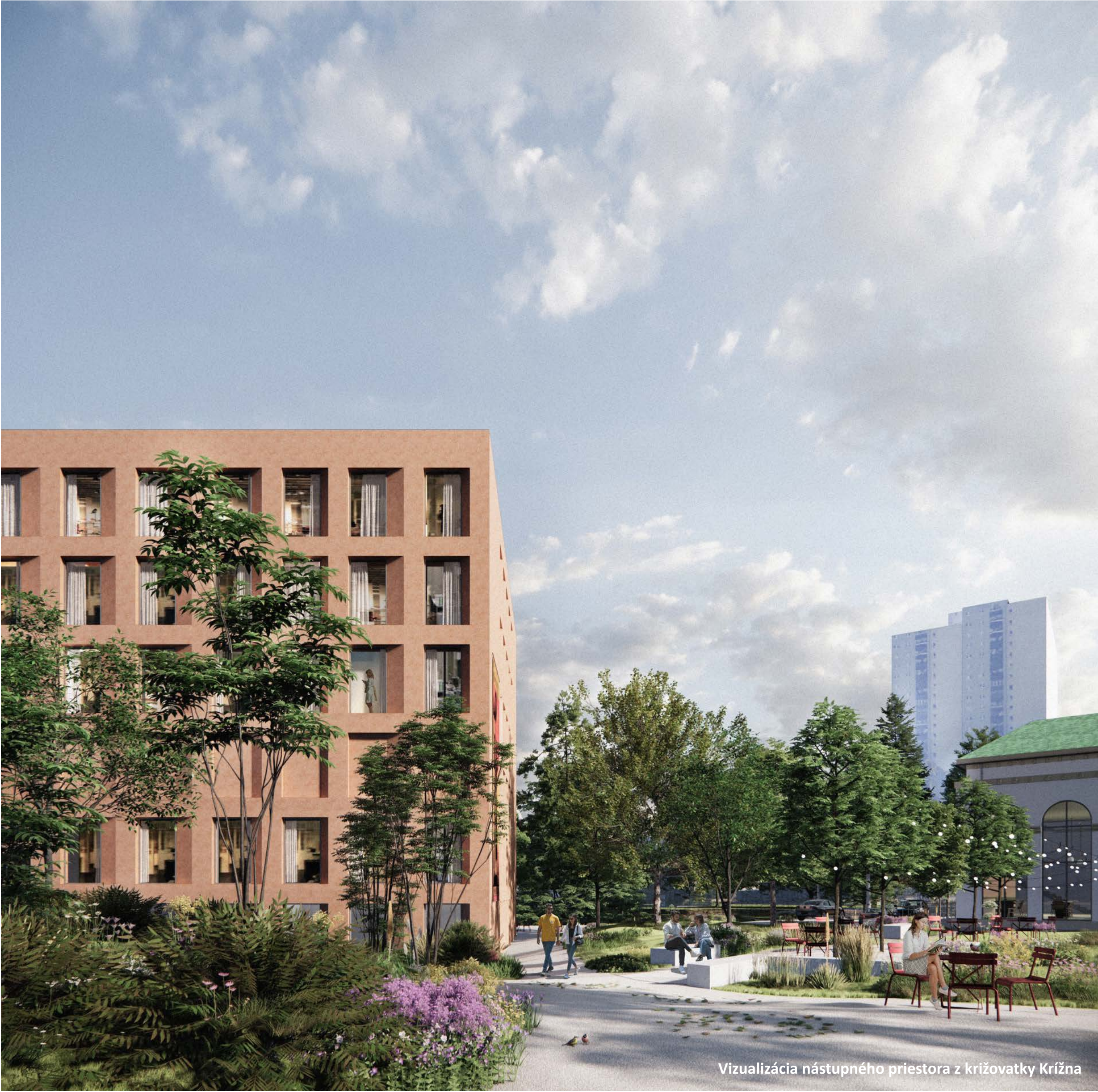
Recyklovaním existujúceho stavebného materiálu vytvárame novú pigmentovanú omietku z tehál. Pôvodný raster okien je upravený aby vytváral pravidelný grid.
