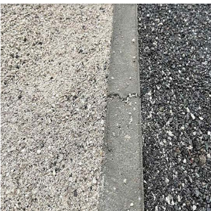
Plocha pod stromami - Ekomlat, obrubník (sivý)
