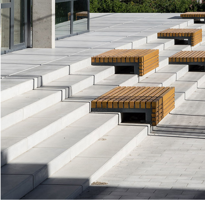
Pobytové schodisko - betón, drevo
