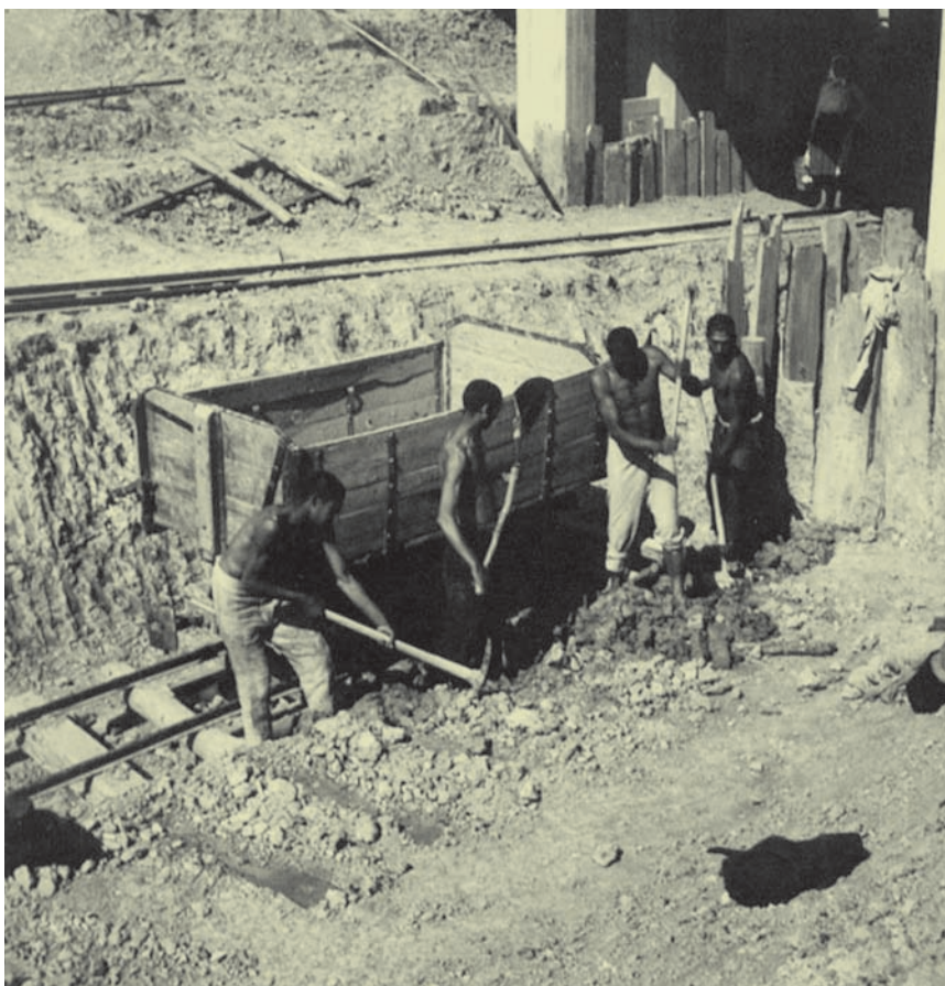
Stavba železničnej trate Prešov – Strážske (Zdroj: Múzeum dopravy v Bratislave)
